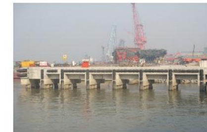
扬州国裕船舶有限公司 码头工程
