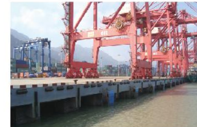
江苏连云港港口股份有限公司 集装箱码头工程
