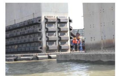
中交第二航务工程局有限公司 福州市螺州大桥工程
