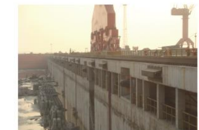
天津新港船舶重工有限责任公司 船坞工程
