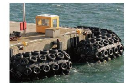
扬州大洋船厂码头工程
